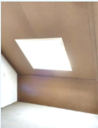
Voorbeeld afwerking hellend dak: niet afgewerkte binnenplaat
