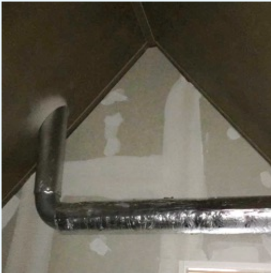
Indicatie m.b.t. WTW kanalen in het zicht (dit is niet het exacte leidingverloop)
