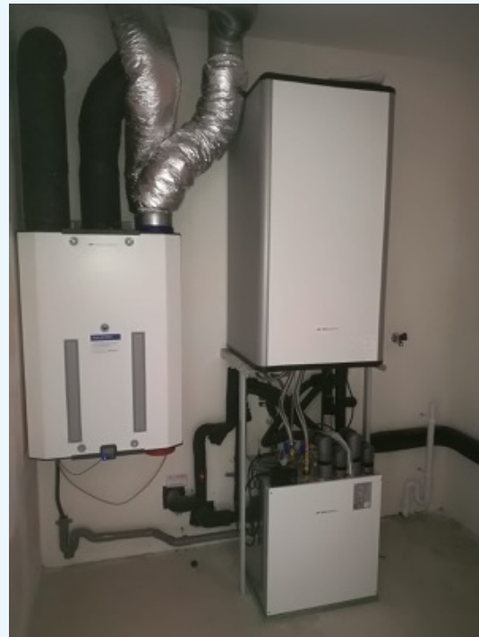
Indicatie aanzicht WTW-unit (links) en warmtepomp met boiler op elkaar geplaatst (rechts), exacte uitvoering kan afwijken.
