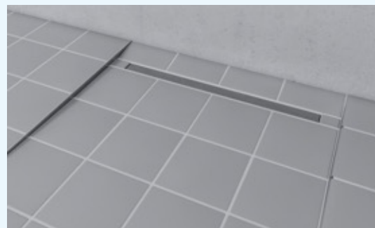
Indicatie aluminium profiel t.b.v. afschot
